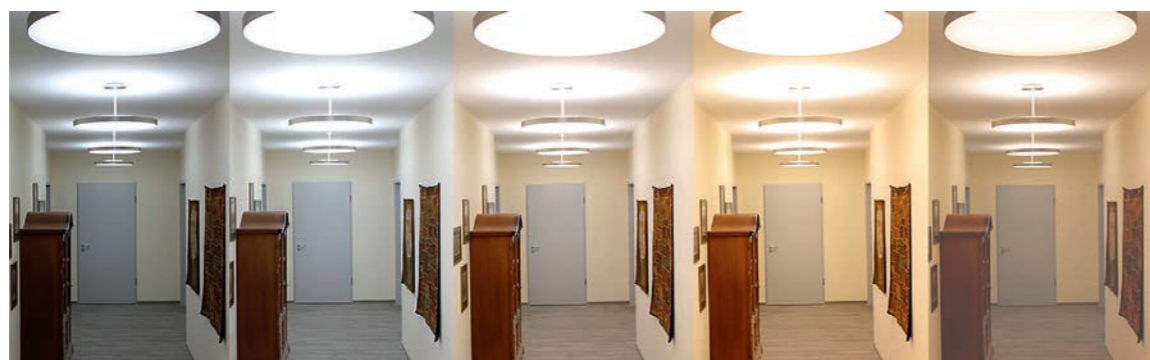
Das Beleuchtungssystem im Projekt „Silverlighting“ wird in seiner Intensität und Lichtfarbe in einer 24-stündigen Sequenz fortwährend gesteuert und ahmt den Tagesverlauf und die Veränderung des natürlichen Tageslichtes nach.
