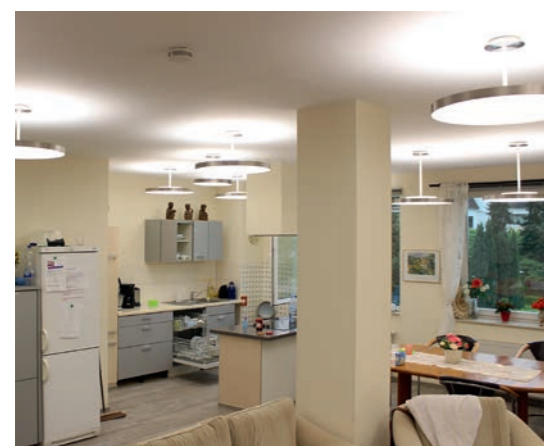
Das Beleuchtungssystem im Projekt „Silverlighting“ wird in seiner Intensität und Lichtfarbe in einer 24-stündigen Sequenz fortwährend gesteuert und ahmt den Tagesverlauf und die Veränderung des natürlichen Tageslichtes nach.
